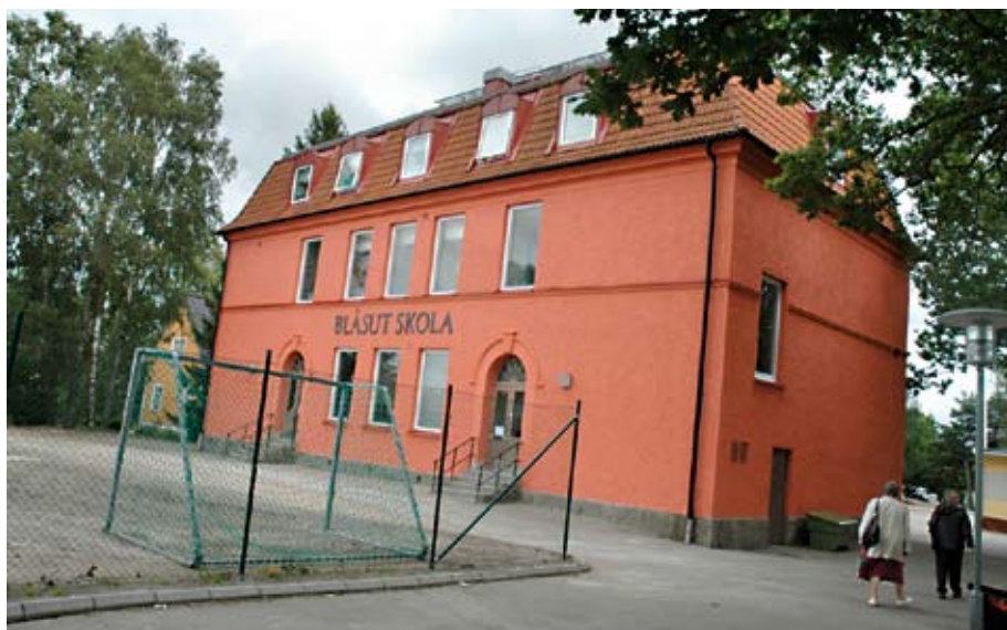
Skolan i Blåsut byggdes år 1912. Efterhand har den byggts ut med fler byggnader intill.
